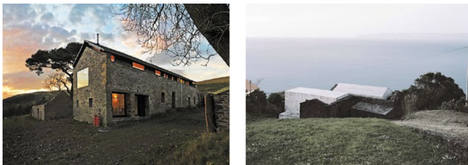
Obr. 7 Ochranná konštrukcia vložená do ruiny – vľavo realizácia od WT Architecture 2014, Spojené Kráľovstvo [19], vpravo od SAMI Arquitectos 2015, Pico [20].
