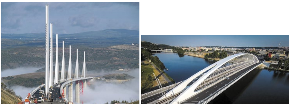
Obr. 2 Ilustrativní fotografie mostní konstrukce Viaduktu Millau [6] - vlevo, (b) Ilustrativní fotografie mostní konstrukce Trojský most [8] - vpravo.
