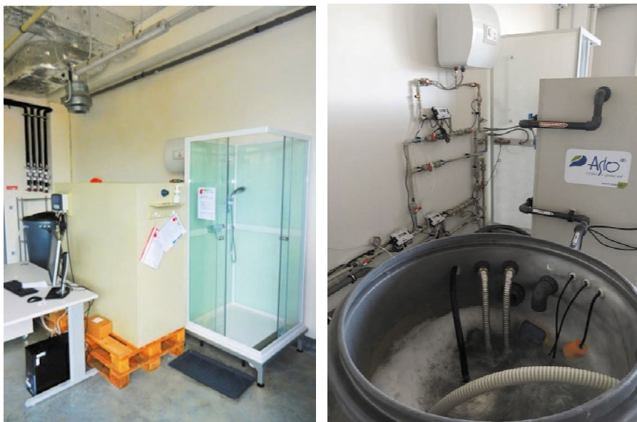
Obr. 2 Vlevo fotografie sprchového koutu a pískového filtru testovacího celku, vpravo detail provzdušňování MBR, fotografie pořízené na AdMaS VUT v Brně.
