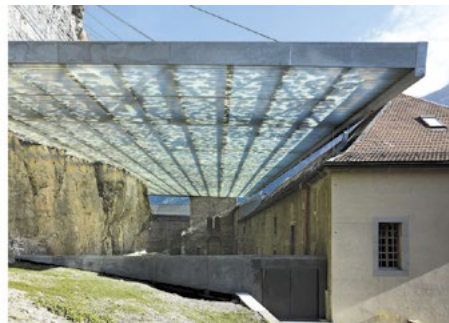
Obr. 3 Krycia stavba nad ruinou v historickom prostredí – vľavo realizácia od GTRF Tortelli Frassoni Architetti Associati 2013, Taliansko [11], vpravo od Savioz Fabrizzi Architectes 2010, Švajčiarsko [12].
