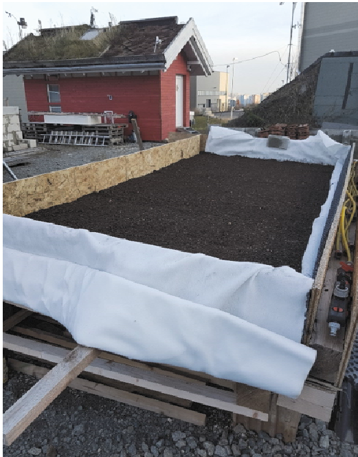
Obr. 3 Klasická extenzivní zelená střecha.
