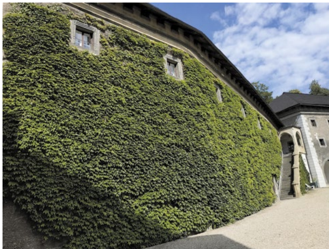
Obr. 1 Fasáda se záměrně porostlou a udržovanou vegetací Parthenocissus tricuspidata . Nádvoří zámku Podstatských-Lichtensteinů, Velké Meziříčí.
