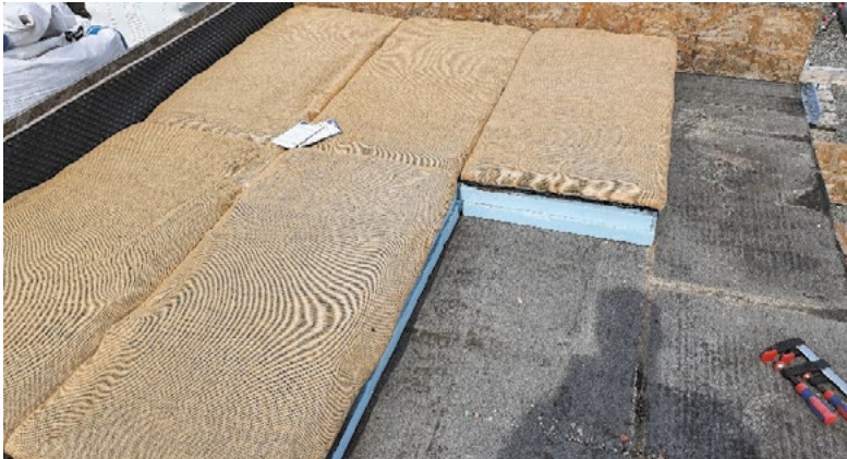
Obr. 2 Konstrukce střechy z předpěstovaných panelů.
