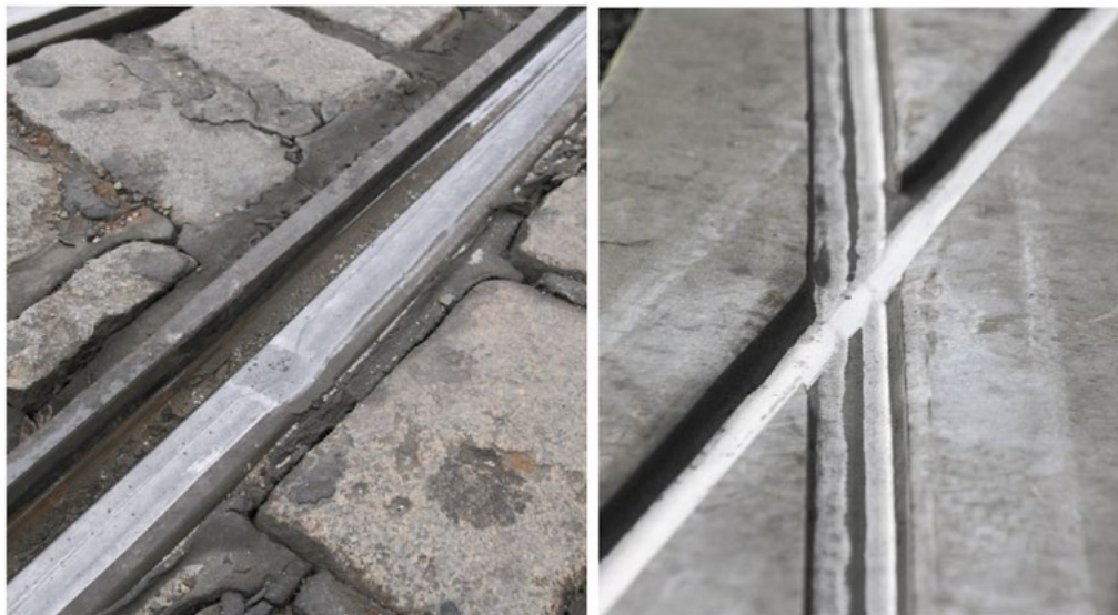
Obr. 1 Svar náběžné a standardní kolejnice (vlevo) a srdcovka výhybky R04 s mělkými žlábkou (vpravo).
