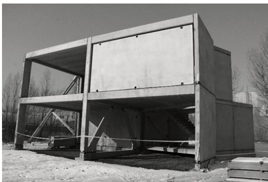
Obr. 1. Prototyp demontovatelné konstrukce
