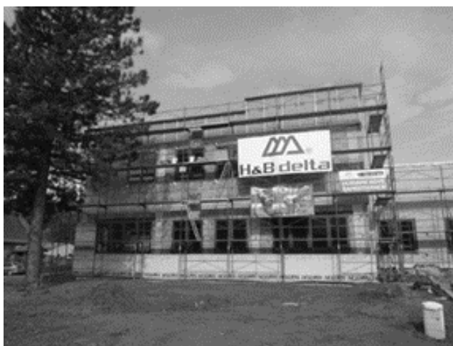
Obr. 1. Budova firmy H&B Delta, s.r.o. – na tomto objektu probíhá měření
