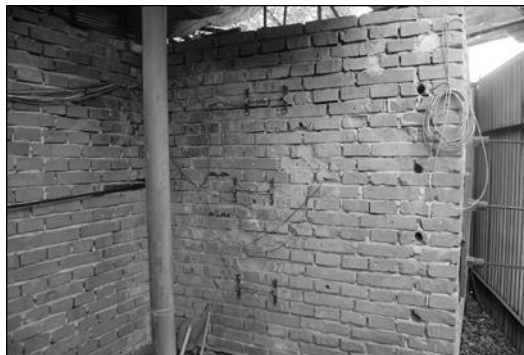
Obr. 1. Pohled na měřené cihelné zdivo, které je horizontálně předpjaté.
