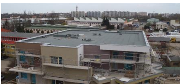
Obr. 1. Realizace střešního pláště a teras
